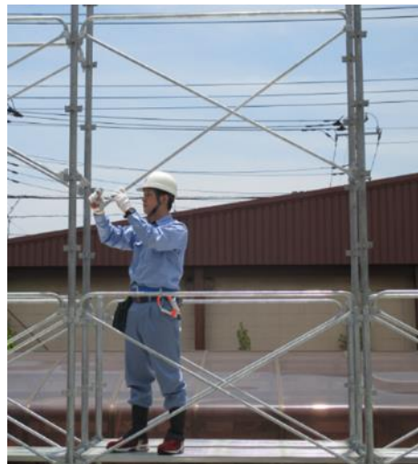
【次世代足場（ファステック）の作業現場】
