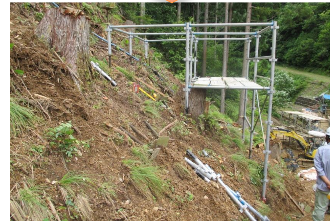
ファステックにて組立試用した作業ステージ
