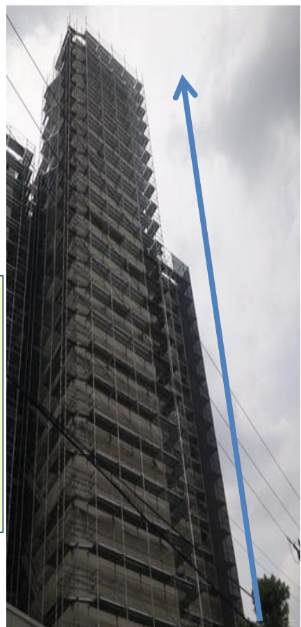
【53m施工実績】
